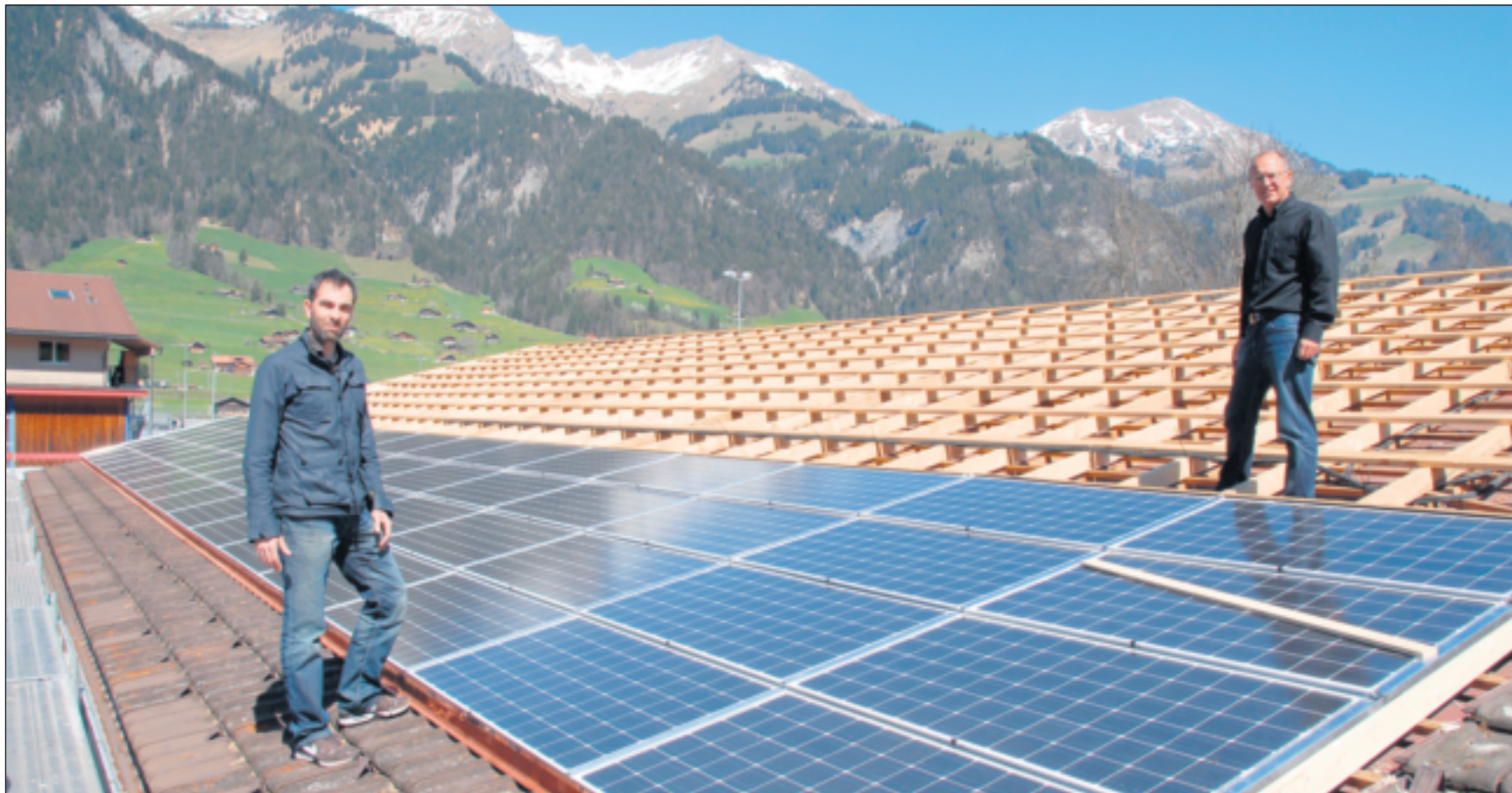
Vahan Bammerlin (l.) und Martin Ryter begutachten den Einbau der neuen Solaranlage auf dem Dach der Bärtschi Bau AG.
